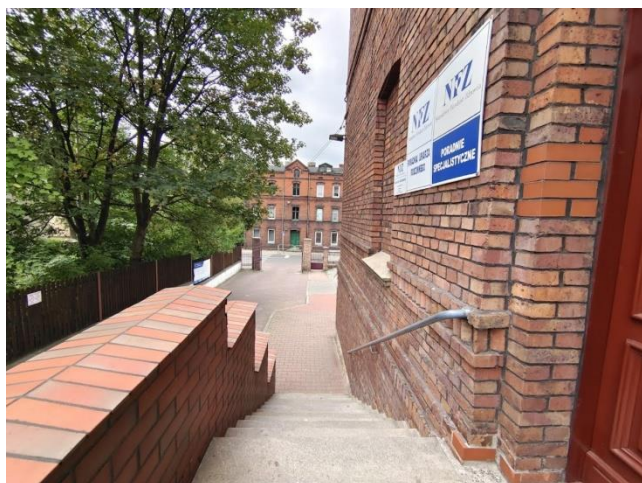
Zdjęcie nr 1: Zejście z przychodni. Brak poręczy na dwóch wysokościach w znaczący sposób może utrudniać jej pokonanie.
