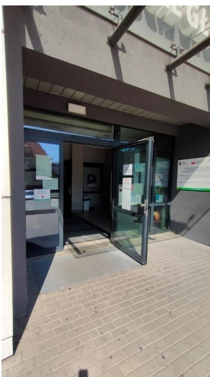
Zdjęcie nr 3: Wejście główne
