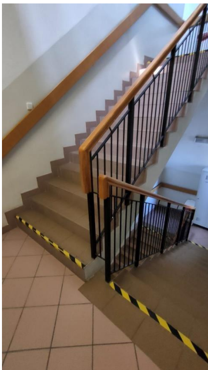
Zdjęcie nr 12: Schody wewnętrzne
