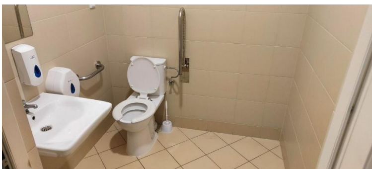
Zdjęcie nr 16: toaleta
