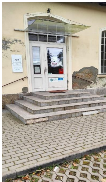
Zdjęcie nr 2: wejście główne
