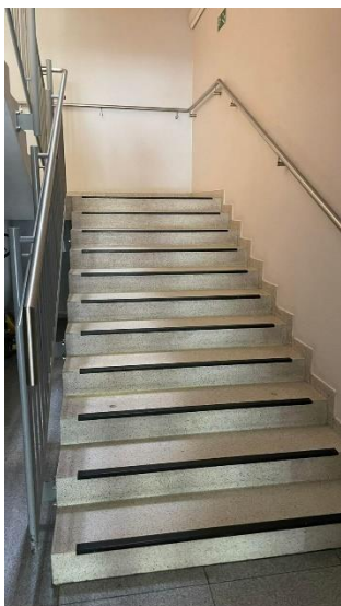
Zdjęcie nr 10: Wewnętrzna klatka schodowa
