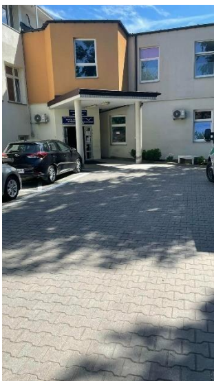
Zdjęcie nr 4: Wejście do Izby przyjęć
