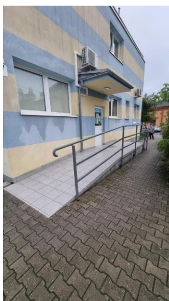
Zdjęcie nr 2: Wejście boczne.
